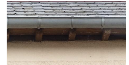
* débord à chevrons saillants avec gouttière demi-ronde
